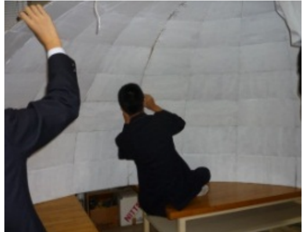
図10 1/4球の端にあけた穴にヒモを通し、外側から結んでドームを組み立てた。
